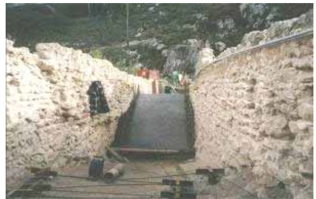
11. Atado cabezas de Micropilotes. 12. Ejecución refuerzo de bóveda conectada.
