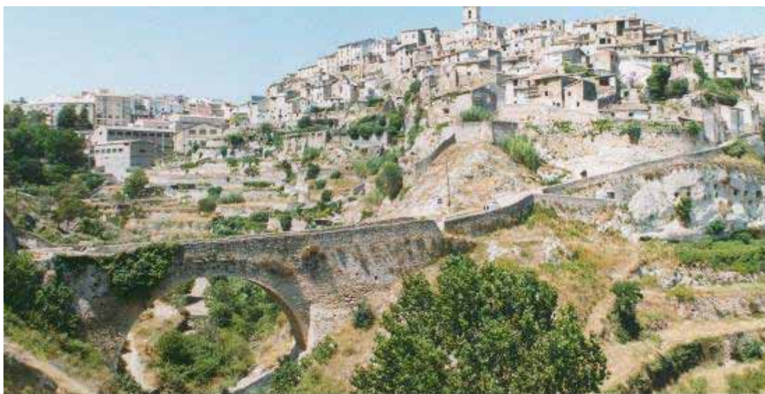
1. Panorámica general del puente antes de la Intervención
