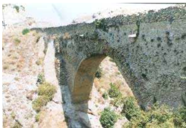
2. Detalle estado dovelas en arranques. 3. Estado general de los paramentos y contrafuertes.
