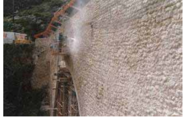
13. Cimbrado de la bóveda. 14. Limpieza de paramentos en tímpanos. 15. Prueba de Carga. Croquis y Modelo.
