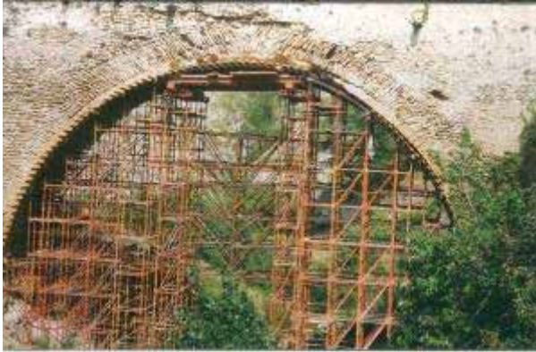
13. Cimbrado de la bóveda. 14. Limpieza de paramentos en tímpanos. 15. Prueba de Carga. Croquis y Modelo.
