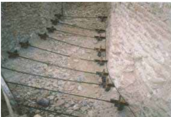
11. Atado cabezas de Micropilotes. 12. Ejecución refuerzo de bóveda conectada.
