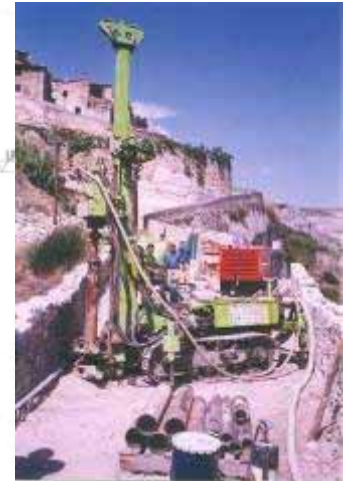
9. Sección longitudinal solución definitiva. 10. Trabajos Micropilotes e inyecciones.
